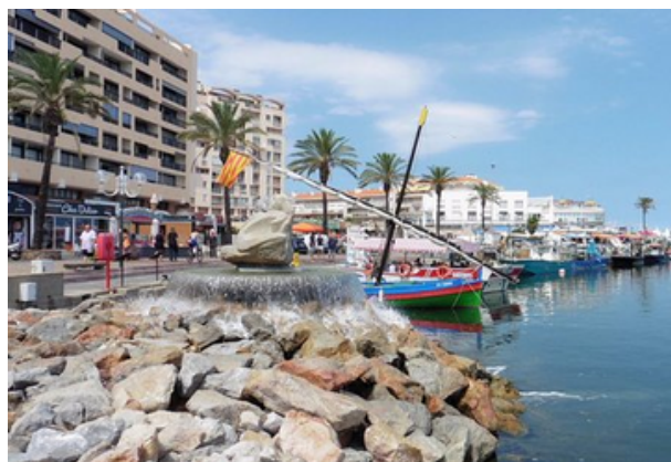
Requalification de la promenade front de mer (tranche 2) à Saint-Cyprien (66)
